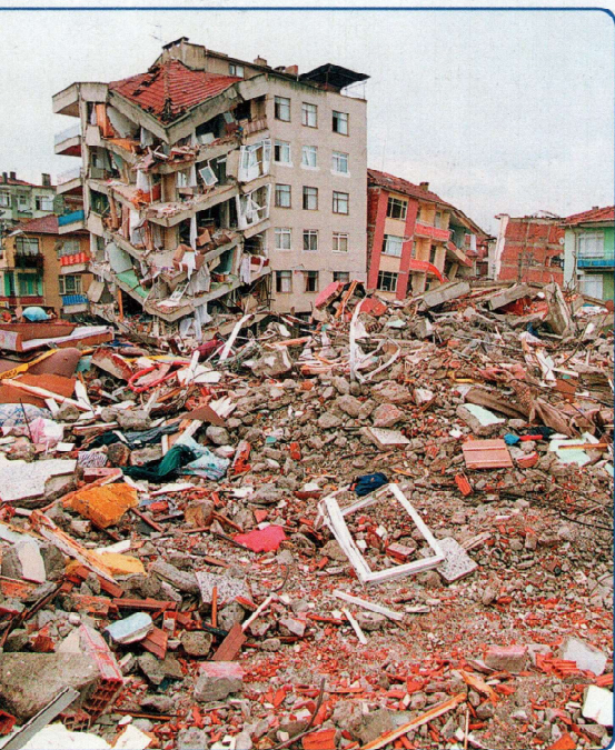
M2 Zerstörungen durch ein Erdbeben
